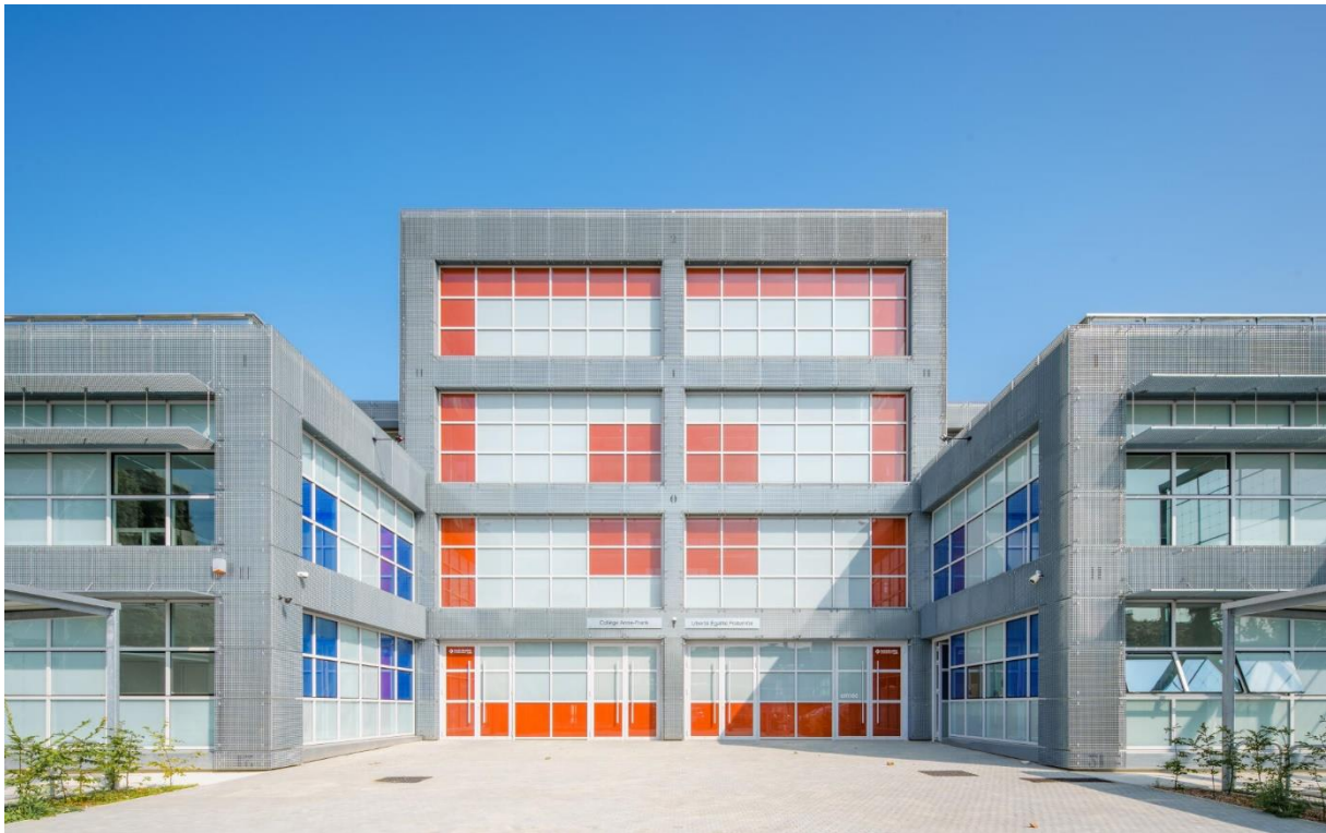
La façade du collège Anne-Frank, de Jean Nouvel, après réhabilitation, à Antony (Hauts-de-Seine), en juin 2023. NICOLAS GROSMOND/MARS ARCHITECTURE
