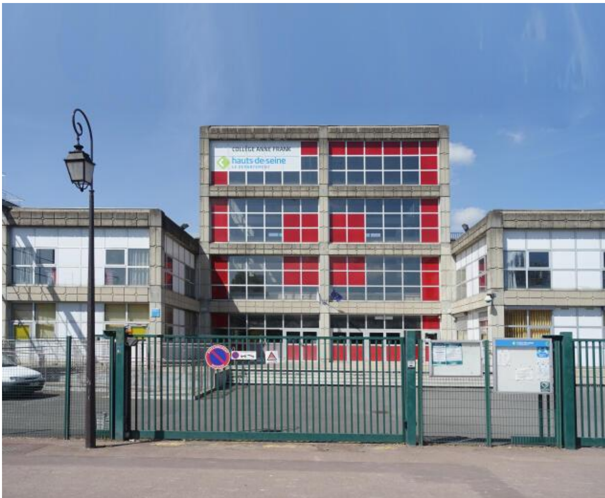
La façade du collège Anne-Frank, de Jean Nouvel, en 2019, avant réhabilitation, à Antony (Hauts-de-Seine). MARS ARCHITECTURE
